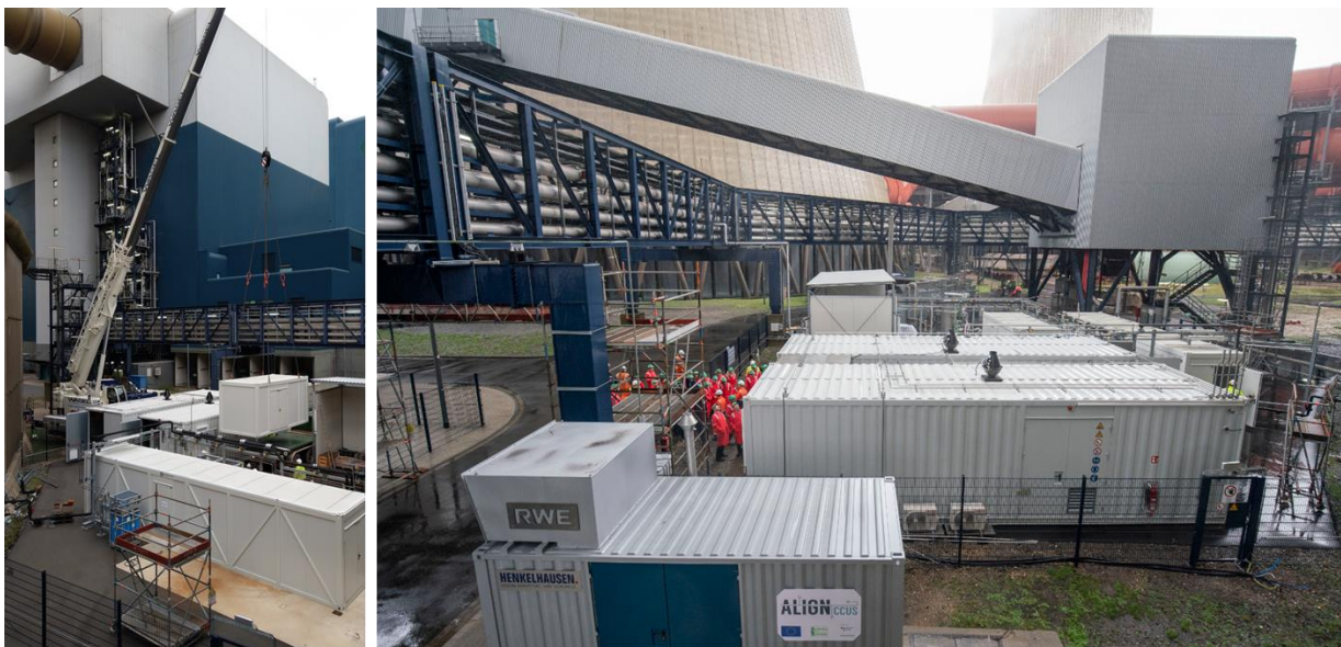
Abbildung 5: Die Errichtung der ALIGN-CCUS-Anlage erfolgte im Oktober 2019. Bild links: Installation des Kompressor-Moduls für die DME-Synthese und CO 2 -Wäsche-Pilotanlage am Gebäude der Rauchgasentschwefelungsanlage von Block K in Niederaußem. Rechtes Bild: vorne links – Stromerzeugermodul; vorne rechts – zwei Container mit der alkalischen Elektrolyse; hinten rechts – drei Container mit der DME-Syntheseinheit; hinten links: offene Einhausung für die Lagerung des produzierten Roh-DME.
